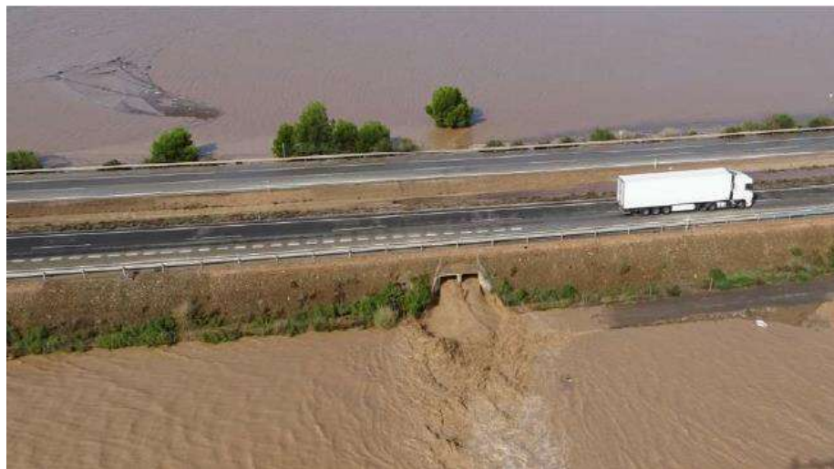
Figura 52. Pasos de agua existentes bajo la autovía, dirigiéndose directamente al núcleo urbano de Los Alcázares. Fuente Green Dry Protect.
